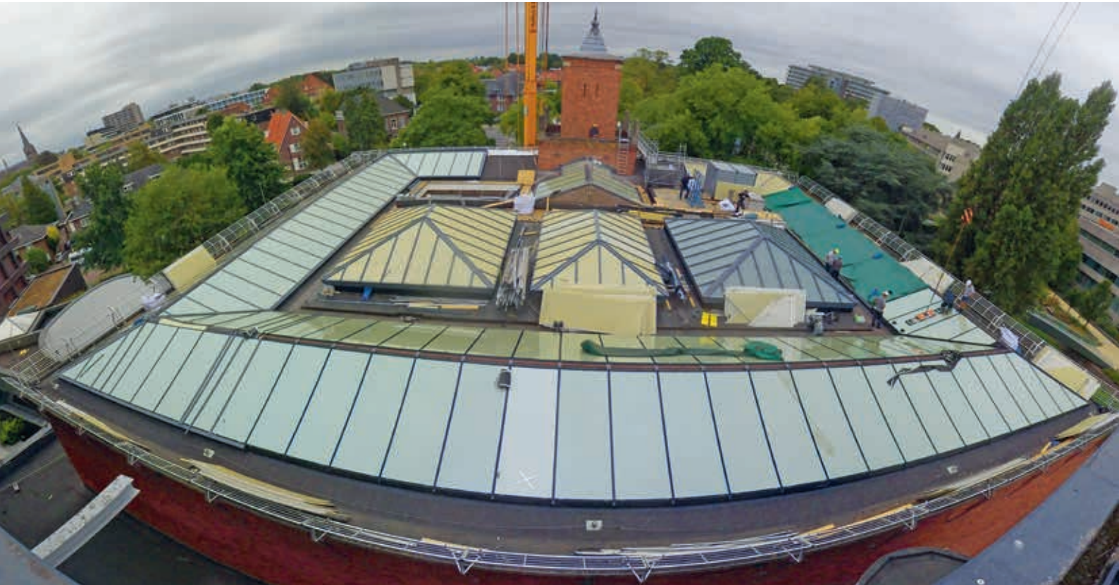
Overzicht van de werksituatie tijdens de renovatie van het monumentale gebouw.
